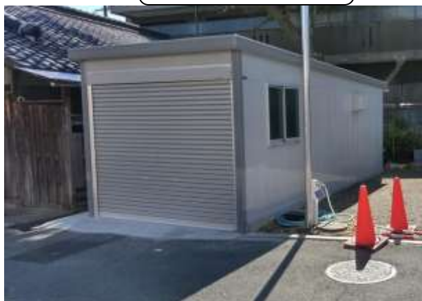
新 SA ハウス外観
